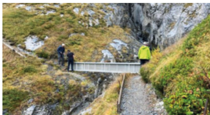
Demontage der unteren Brücke.
